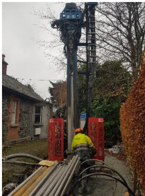
Installation de l'échangeur de chaleur
