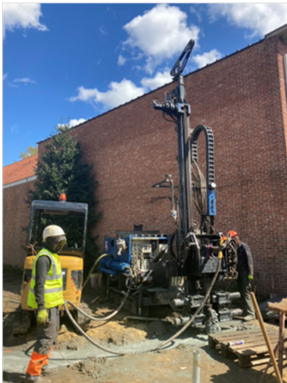
Ανόρυξη γεώτρησης γεωεναλλάκτη ΤΚΙ
