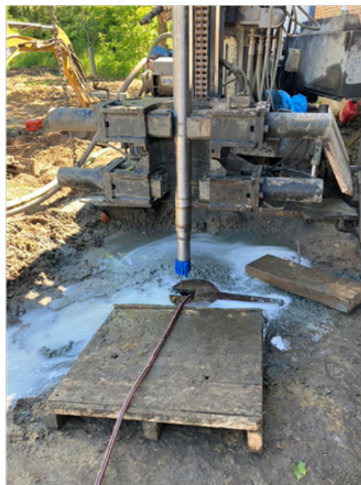
Έναρξη της γεώτρησης με τη μέθοδο Hydra-Red
