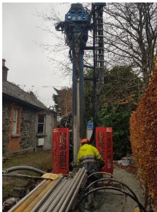
Εγκατάσταση του γεωεναλλάκτη
