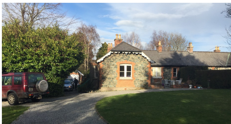
Standort der Fallstudie Greystones mit der Vorderseite des Gebäudes und der Position der Erdwärmetauscher in der Einfahrt links vom Haus
