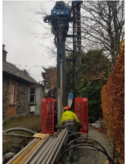
Einbau der Erdwärmesonde
