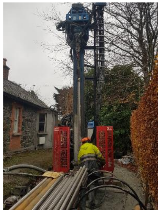
Installazione dello scambiatore di calore
